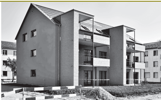
Blick auf eines der vollendeten Häuser der Überbauung
