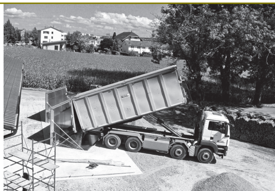
Erste Anlieferung von Holzschnitzel
