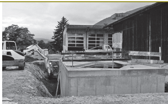
Bau des Schnitzelsilos
